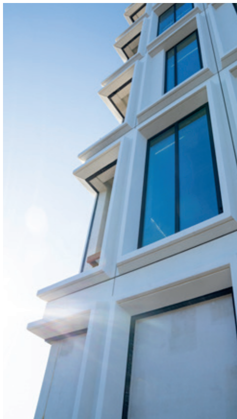
Strakke hoekdetailering van het kantoorgebouw Fotostudio Eye 4 You
